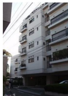
〈補強前東側外観〉
