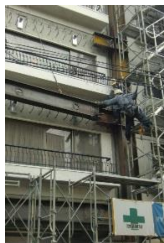
SRC 補強フレーム鉄骨建方
