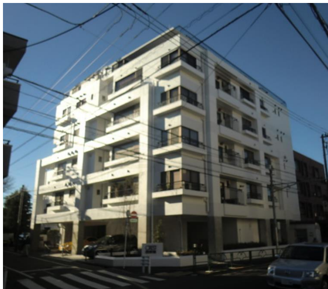
補強後の東北側外観
