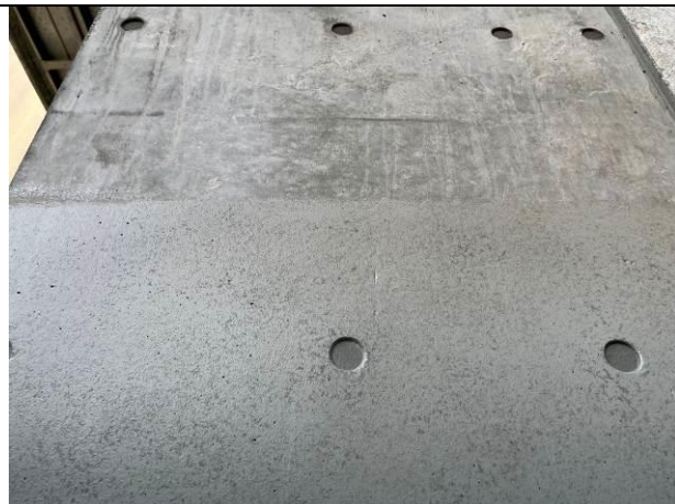
水系フッ素塗料（下）とコンクリート素地（上）
