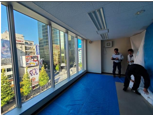
補強フレームの開口にサッシ/カーテンウォールを設置
