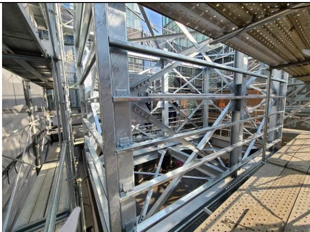
建て方が完了した屋上看板
