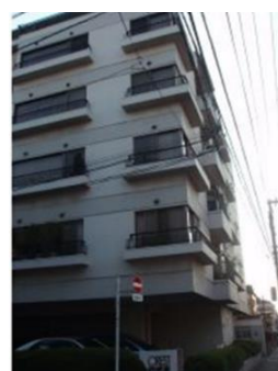
〈補強前東北側外観〉
