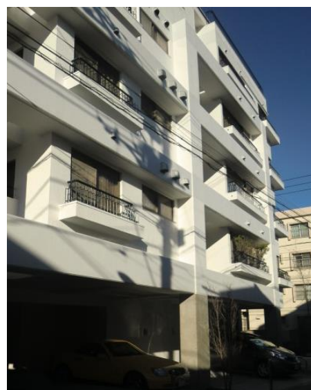
水平梁、花台、バルコニー、排気口
