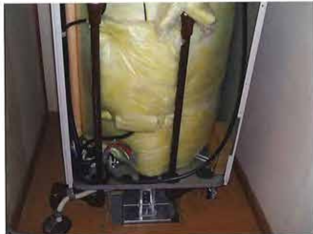
写真4 電気温水器の耐震改修事例 スラブへ設置した架台の上に温水器を乗せ、ボルト固定 する。
