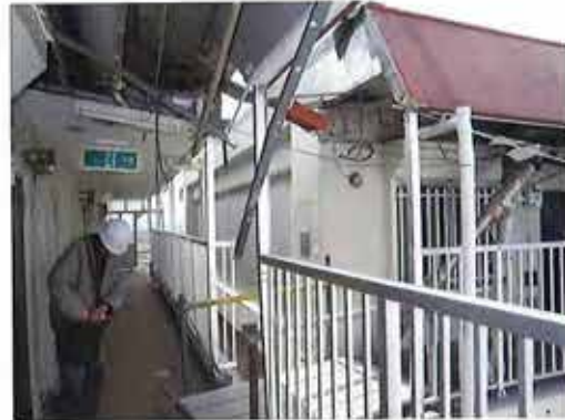
建物を繋ぐエクステンションジョイント部分は、地震時に複雑な揺れとなり上階ほど大きく揺れる。 写真は東日本大震災においてメインの給水管がエクステンションジョイント通過部分で脱落してしまった事例
