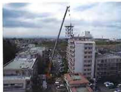
高層水塔を高層台と共に撤去した
