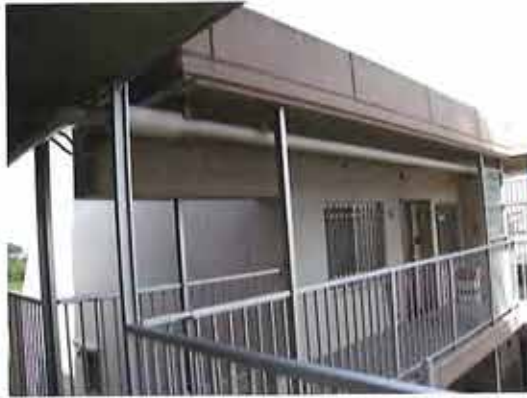
建物を繋ぐエクステンションジョイント部分は、地震時に複雑な揺れとなり上階ほど大きく揺れる。 写真は東日本大震災においてメインの給水管がエクステンションジョイント通過部分で脱落してしまった事例
