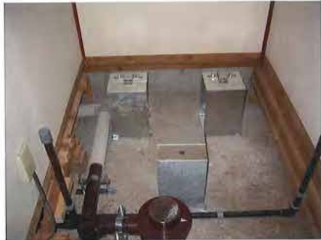
写真3 電気温水器の耐震改修事例 フローリングを撤去し、架台をケミカルアンカーにて スラブへ固定する。
