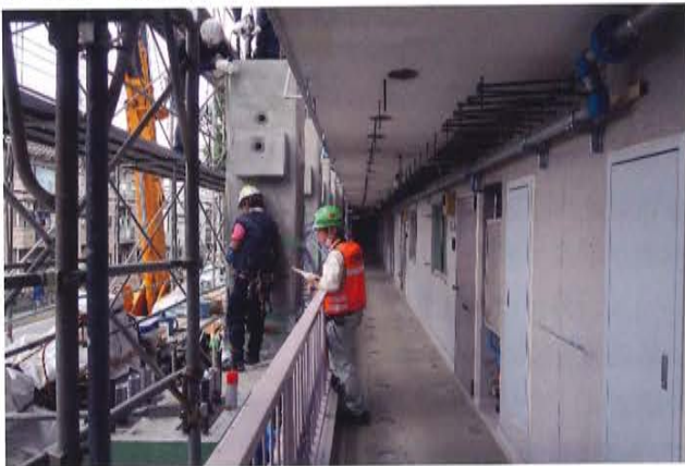
PC部材 組立作業 2
