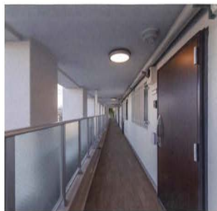
外廊下 (対震扉・ガラス手摺)
