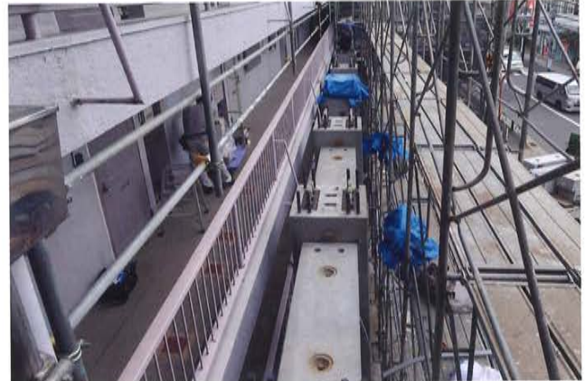
PC部材 組立作業 1
