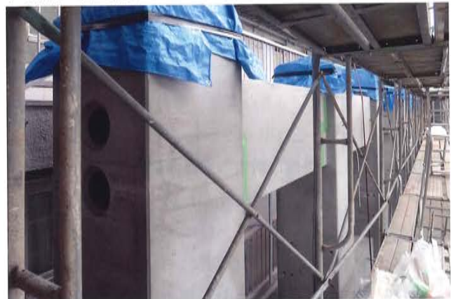
PC部材 組立作業 3
