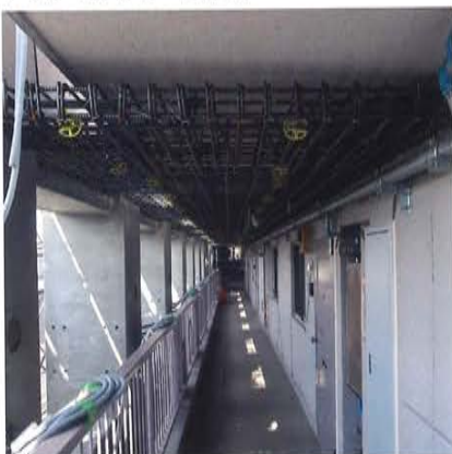
接続スラブ配筋
