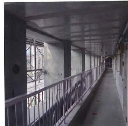
接続スラブコンクリート打設
