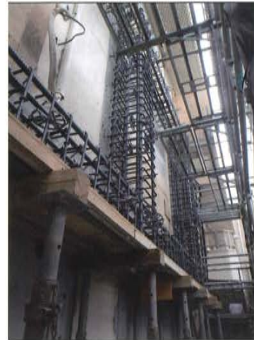
フレーム工事中 パルコニーを撤去して施工
