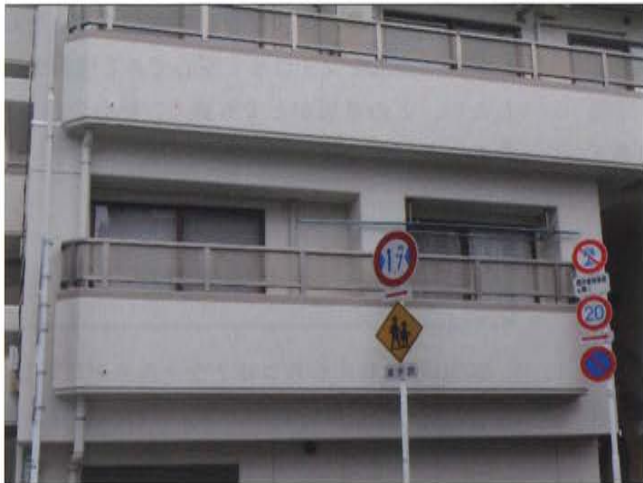
フレーム取付部
