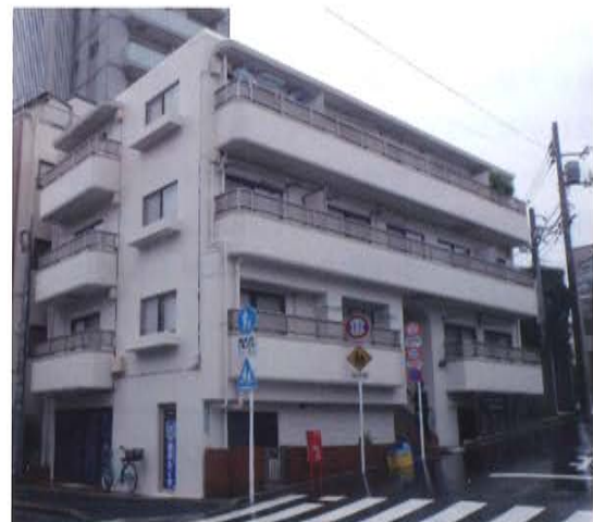
耐震補強工事後
