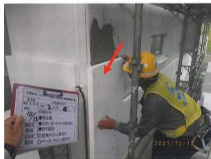
外壁への断熱材取り付け状況
