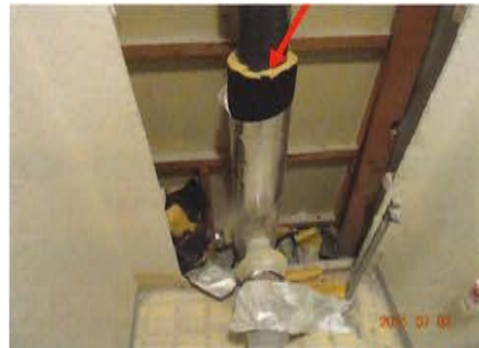
トイレ排水管更新中
