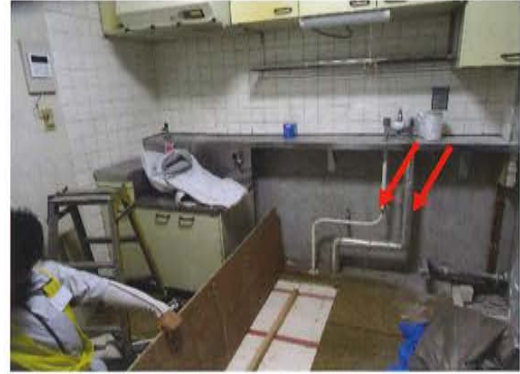
住戸内給排水管更新中
