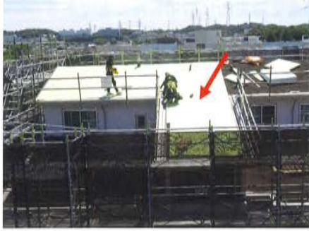
屋根の断熱材工事中
