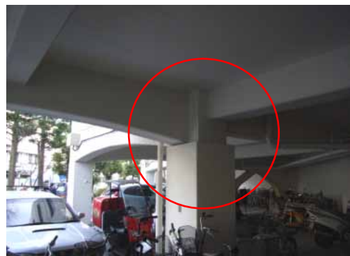
コンクリート打ち増し4層巻き（段差大）
