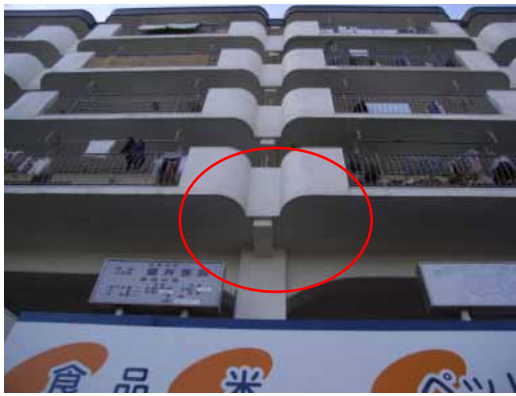
1 階店舗部柱と上層部
