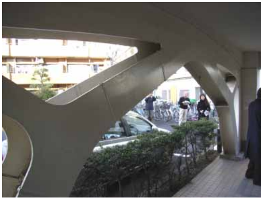
妻側ブレース（内部）
