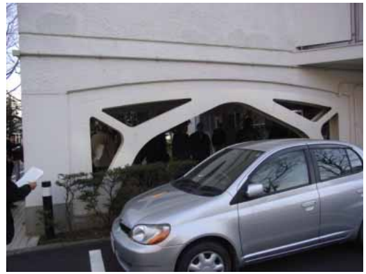
妻側ブレース（外部）
