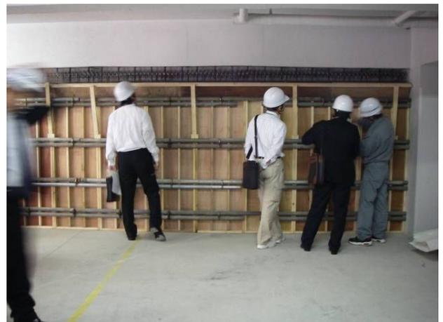
耐震壁増し打ち箇所（打設前）
