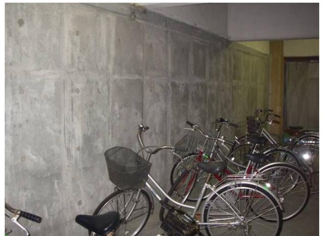
1階ピロティー部の補強(新設壁)
