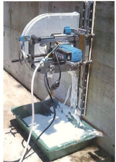
AWAユニットからウォールソーに泡を供給しコンクリート壁を切断。低騒音・低振動・無粉塵・低切削汚水が実現。
