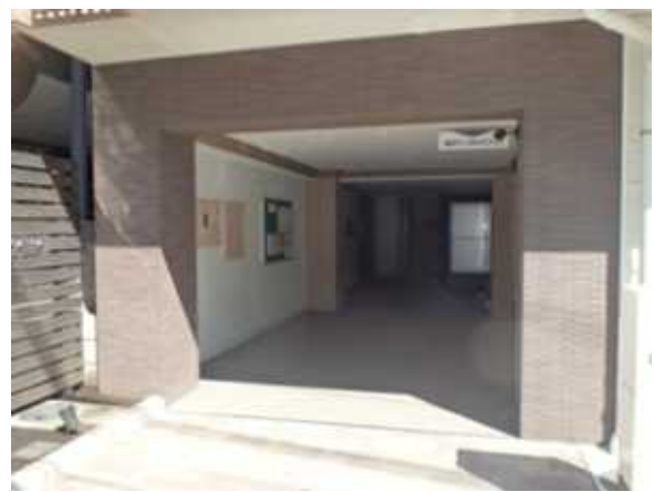
改修後のエントランス入口 右の柱を35cm内側に増し打ち
