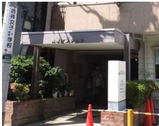
改修前のエントランス入口
