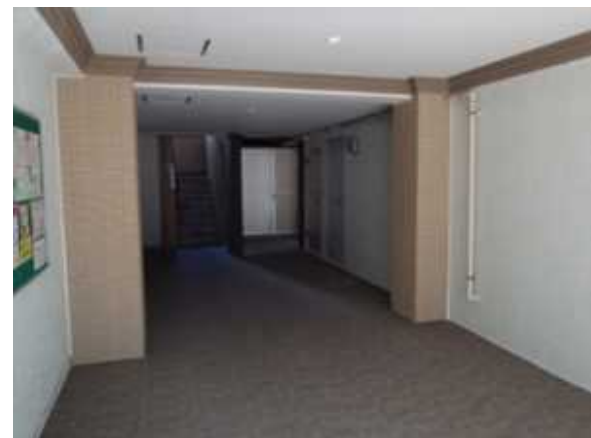
改修後のエントランス 手前の天井の高さを上げた
