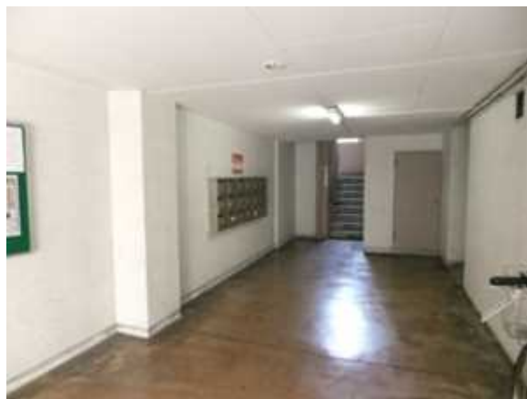
改修前のエントランス
