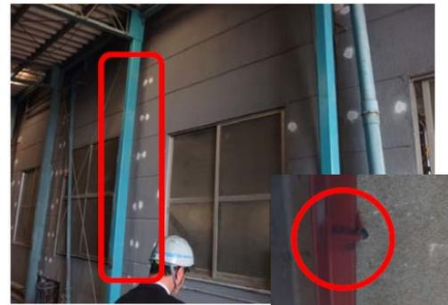
ALC 版脱落防止 上: 白い丸部分はボルト挿入位置 右: 裏側の間柱留め部分
