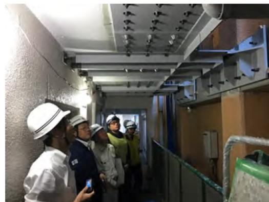
(左上) 鉄骨階段のブレース・方丈補強
