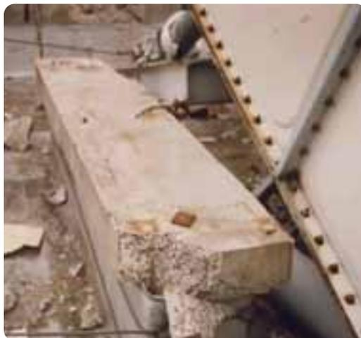
地震により基礎から脱落した高置水槽
