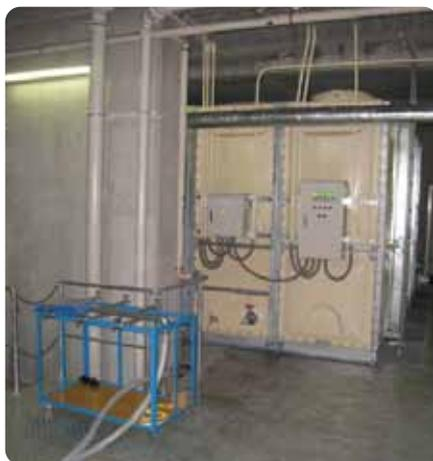
受水槽を耐震型に改修し「緊急遮断弁」を設置した。大地震が来ると自動閉止し水の供給を止め備蓄する。備蓄した水を取り出せるよう移動式の水栓台も作った事例。
