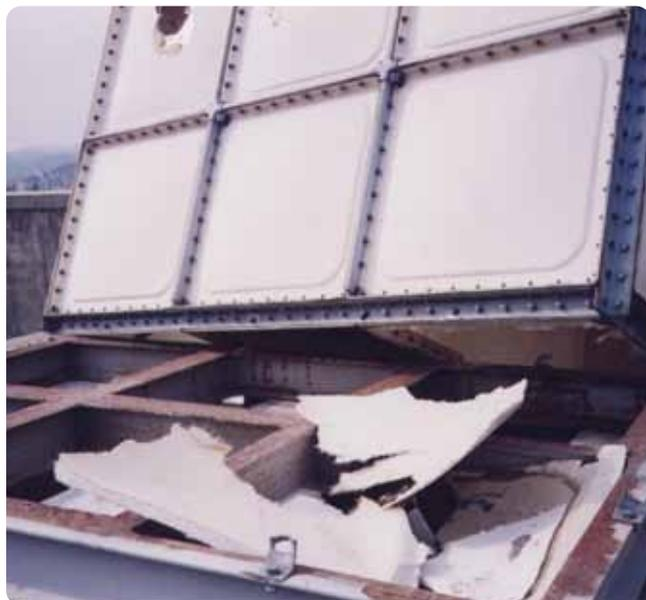
地震により転倒した高置水槽
