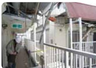
建物を繋ぐエキスパンションジョイント部分は、地震時に複雑な揺れとなり上階ほど大きく揺れる。写真は東日本大震災においてメインの給水管がエキスパンションジョイント通過部分で脱落してしまった事例。
