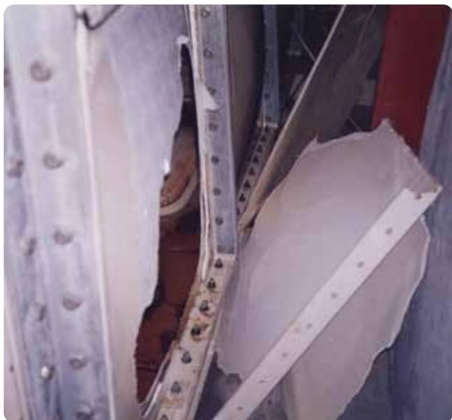
地震により破損した高置水槽
