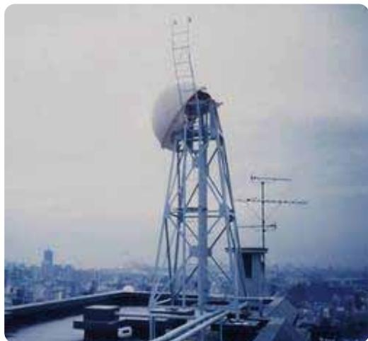
地震により破損した高置水槽
