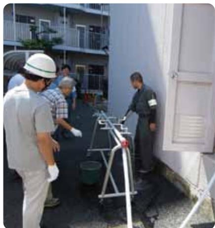
直結化により不要となった受水槽を非飲料用水槽として残し、非常時に取水できる移動式の水栓台を作った事例。少しでも新しい水を補給させたいので、平時は排水管高圧洗浄などに使用している。
