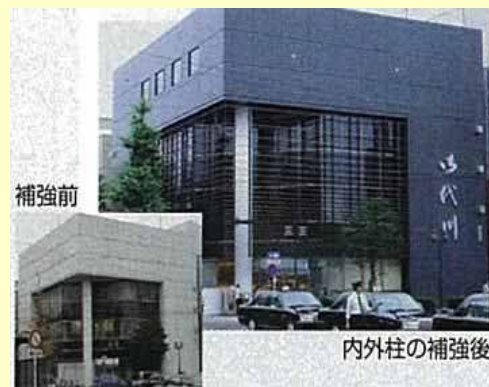
補強後も建物のデザインは保持された
