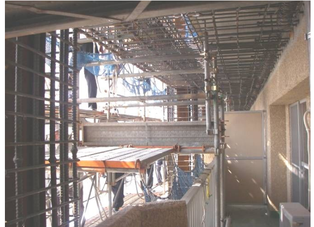
アウトフレーム打設前
