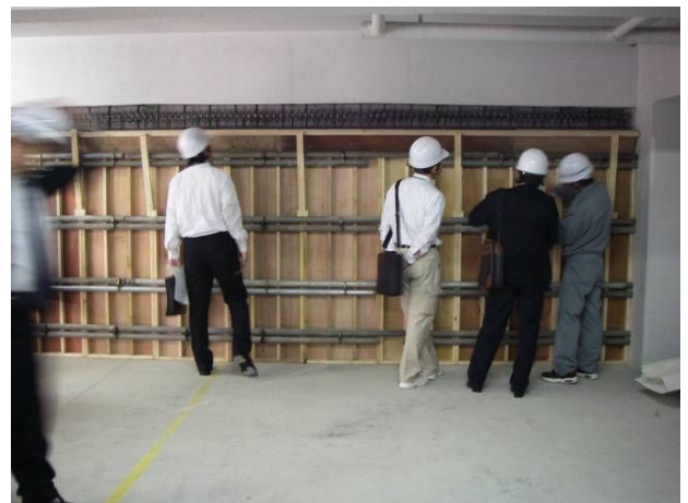
耐震壁増し打ち箇所（打設前）
