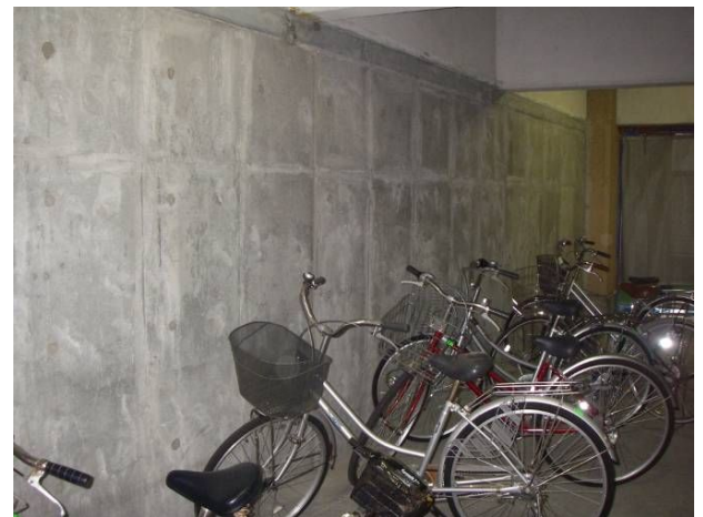
1階ピロティー部の補強(新設壁)
