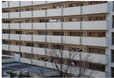
開口部の手前にブレースが見える
