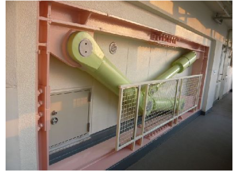
廊下側はALC版と制震ブレースを設置
