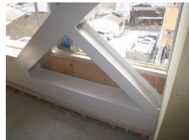
下端の型鋼には蓋がされている
