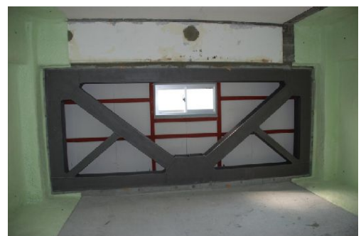
廃止住戸の戸境壁は断熱材吹付けに
