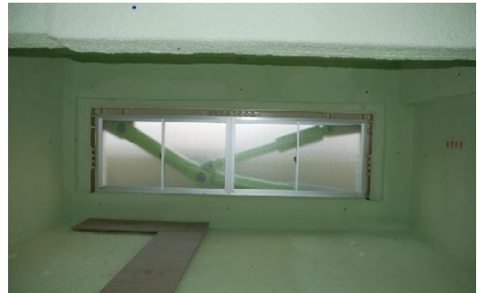
ブレース搬入・組み立てのため、住戸の間仕切り壁が取り払われた住戸。吹付断熱材で覆われて、薄緑色の不思議な空間に。まるでアート。
