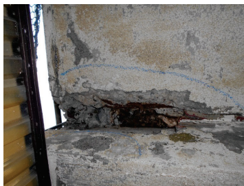
コンクリートの剥落、欠損
