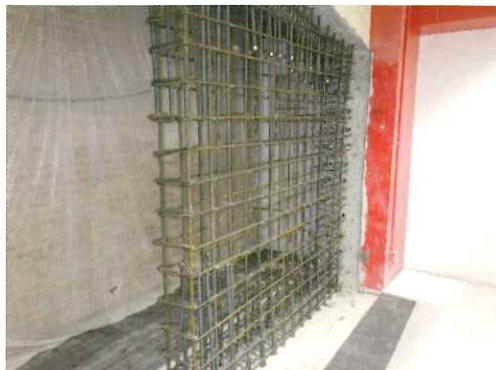
補強袖壁配筋状況
