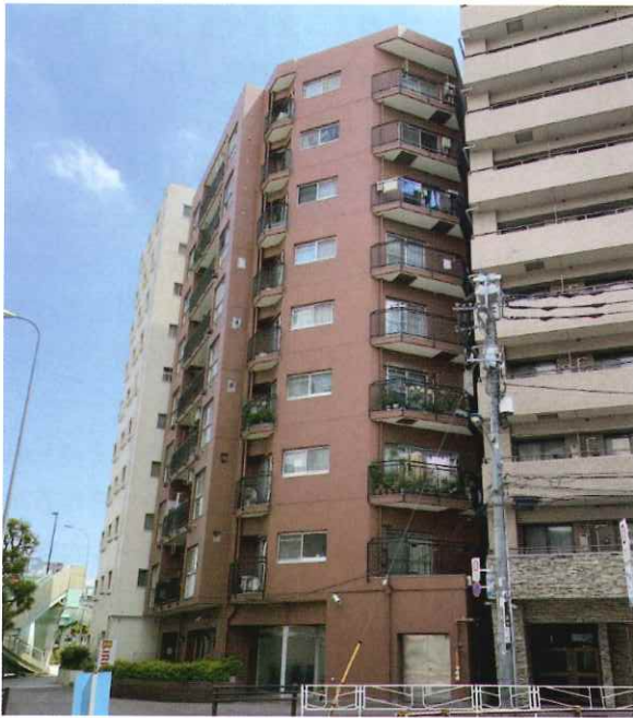
トーカンマンション王子 建物全景
