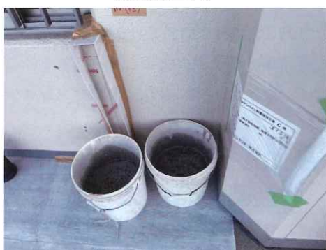
スリット削孔準備 MIYAGI architects & engineers
