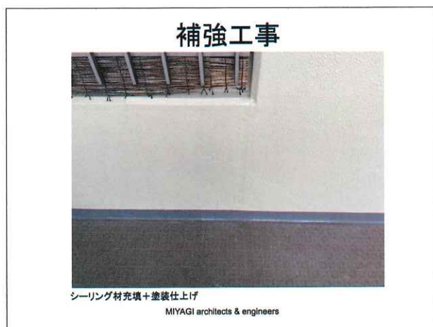
図 20 シーリング材充填・塗装仕上げ状況
