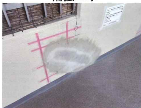
ポリマーセメントモルタル修復 MIYAGI architects & engineers
