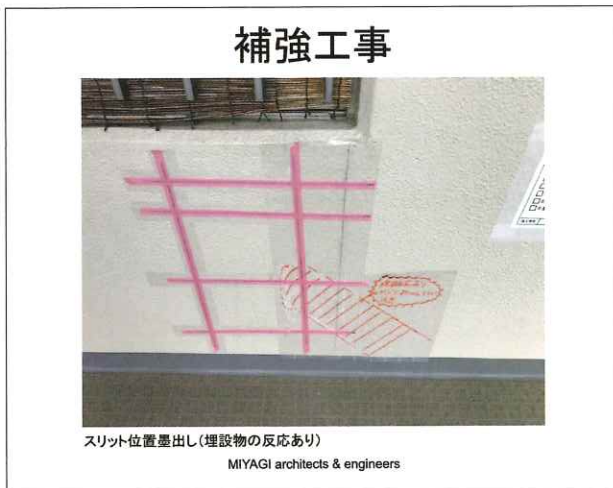
図 13 補強工事：スリット位置の墨出し
