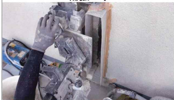
スリット削孔ムービー MIYAGI architects & engineers
