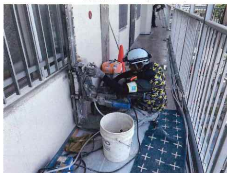
スリット削孔 MIYAGI architects & engineers
