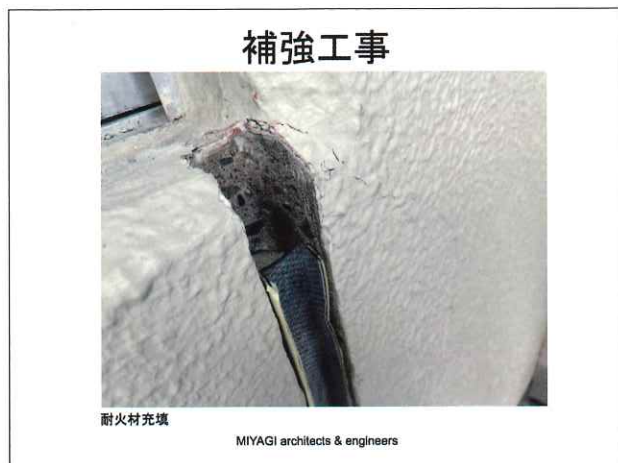
図 19 スリット削孔後の耐火材充填状況
