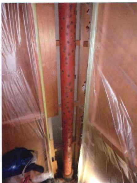
写真10 Phase3 斑点状の模様が増殖、この時点で末期状態(要更新)と判定できる。
