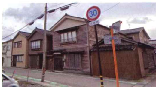
写真 3 輪島市河井地区 地震前 google より
