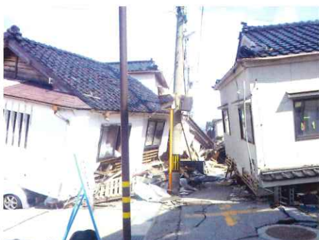
写真 14 輪島市河井地区
