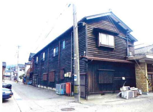
写真 17 輪島市河井地区
