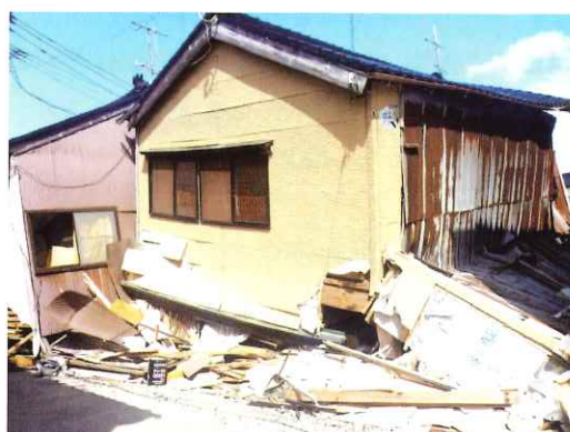
写真5 輪島市河井地区
