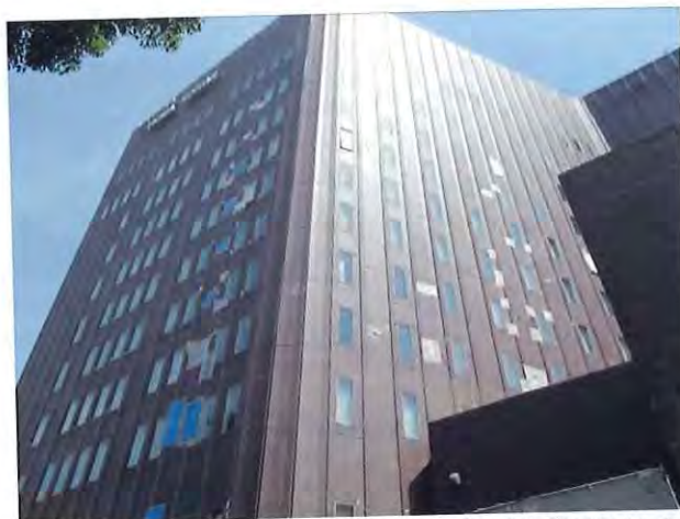
写真5 熊本市中心街にあるホテルでは雑壁に被害が確認されたが修繕を行ない、被災から1年後、営業を行なっている。
