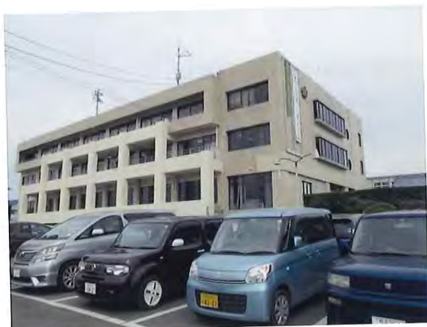
写真2 建替えが決まった益城町役場。 建物は耐震補強工事を行なったが杭基礎に被害があった。
