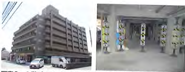
写真8 1階ピロティ柱頭部に軽微な被害が確認されたマンション。梁下にウマを噛ませ応急処置を行なう。
