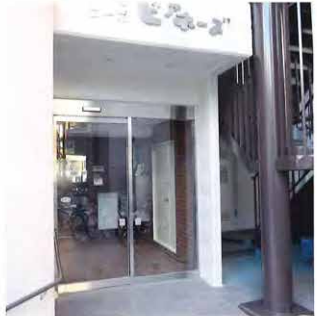
写真6 エントランス改修 段差の解消、自動ドア設置、大型ポストへの交換など生活の利便性を向上させるグレードアップ工事を実施
