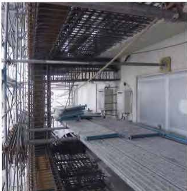
写真5 外付けフレームの工事 工事中の約3カ月間、バルコニー側の出入口は封鎖され、工事が進められる
