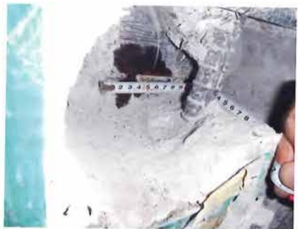
写真4 鉄骨柱フランジ幅の測定状況
