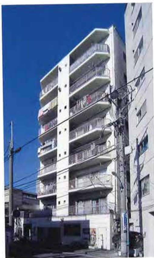
写真1 改修前 工事前の外観。鉄部のサビや外壁の塗装の劣化が進行している為、耐震補強と大規模修繕を同時に実施することになる
