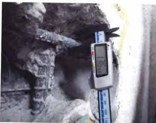
写真3 鉄筋の測定状況
