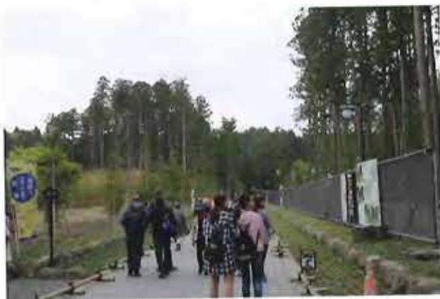
復旧工事中の瑞巖寺の参道
