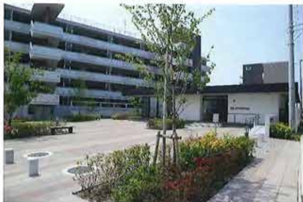
新門脇地区の復興公営住宅、B街区
