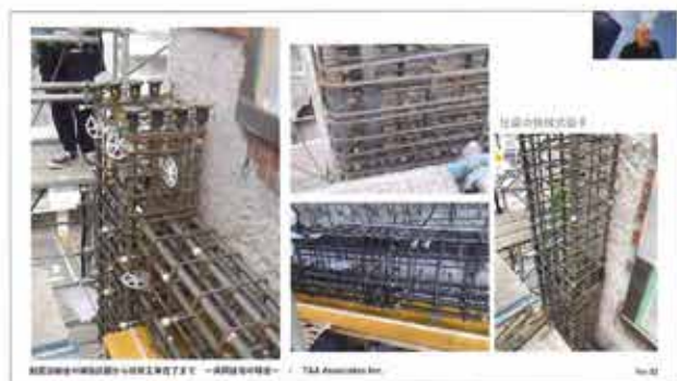
図32 実際の配筋の写真
