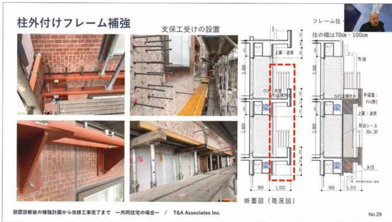
図 29 柱外付けフレーム補強
