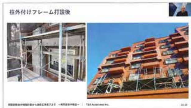
図33 柱外付けフレーム打設後
