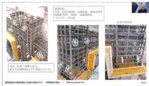
図31 実際の配筋の写真
