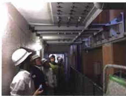
主棟の共用廊下床スラブと副棟の梁と柱を繋ぐ
