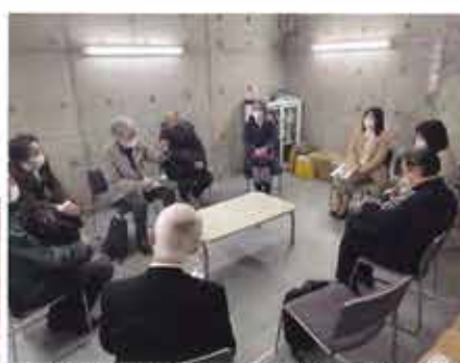
旧受水槽室の壁増し打ち 旧受水槽室に床を張って集会室にコンバージョン
