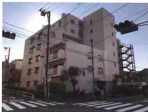
補強後の外観
