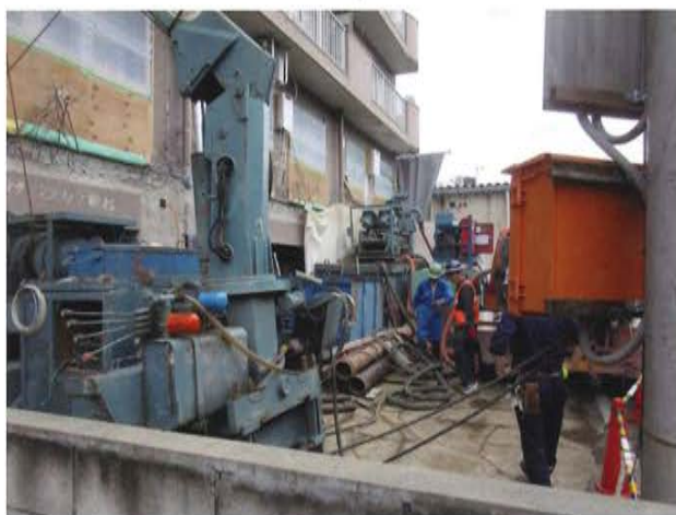
2階のバルコニー撤去しての杭工事
