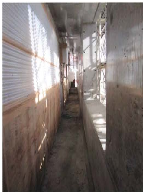
工事中のアウトフレーム打設後バルコニーの様子
