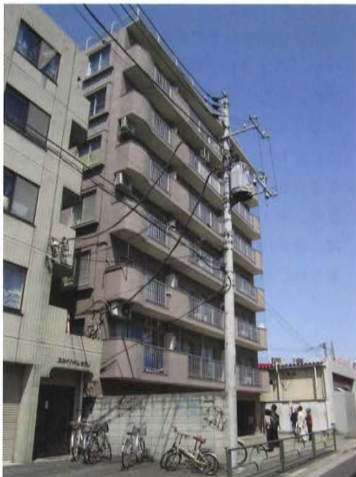
改修前南面外観
