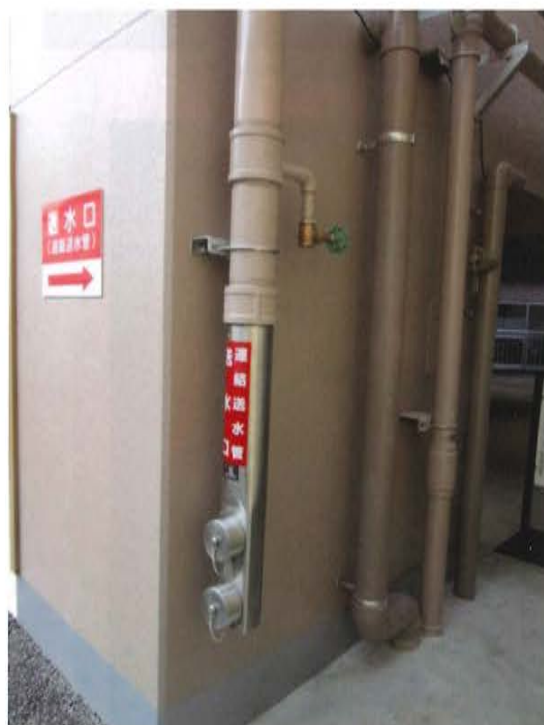
改修後 建物前にあった送水管をアウトフレーム横に移設
