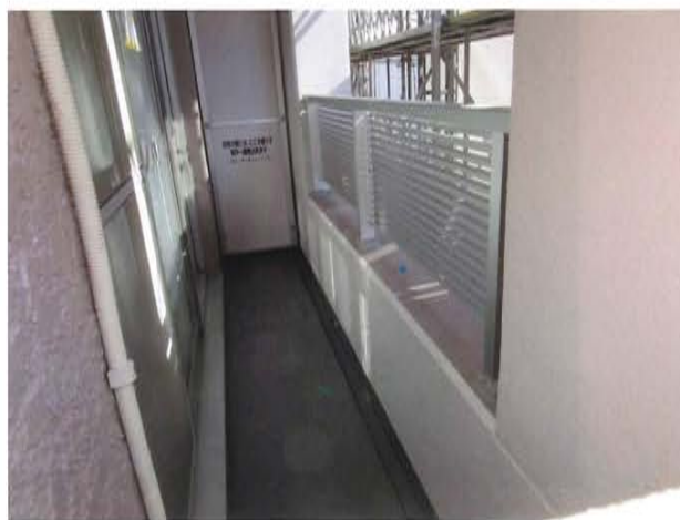
アウトフレーム設置後バルコニーの様子 隣戸避難経路の幅員は改修前と変わらず
