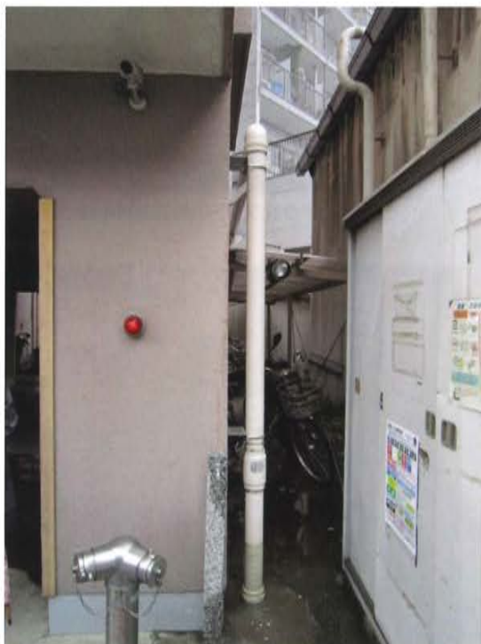
改修後 建物前にあった送水管をアウトフレーム横に移設
