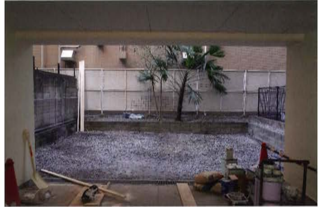
誓約書通り、物置は工事中に全て撤去した 給水設備改修によって受水槽も撤去され、工事中はこのスペースに 現場事務所を設置することができた他、工事後は見通しの良い空間 になった
