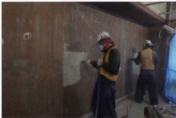
ビシャン叩き電動工具による剥離目荒し施工状況
