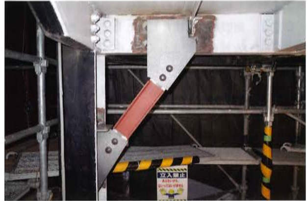
鉄骨階段の踊り場頬付け補強
