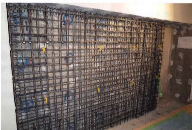
増し打ち壁補強箇所
