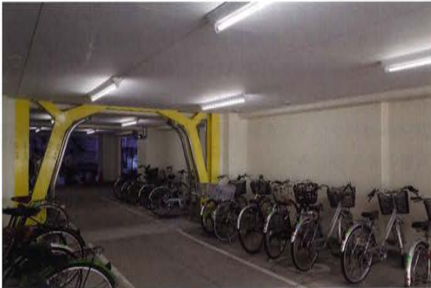
枠付鉄骨ブレースはマンサード型にし、 下枠を土間コンクリートに埋めて通行に支障ない納まりとした
