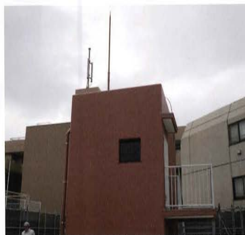
給水設備システム変更 施工後(耐震化)
