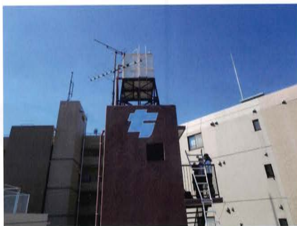
給水設備システム変更 施工前
