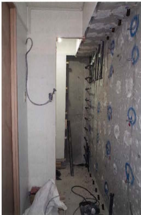
狭い施工空間であったが、区画養生が上手く できたため、作業は効率よく進んだ
