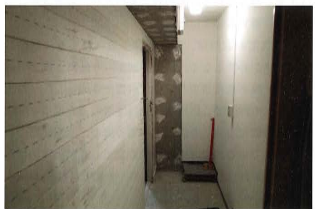
SRFシート張り箇所
