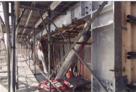
ブレース設置完了。工事完了までバルコニー使用不可
