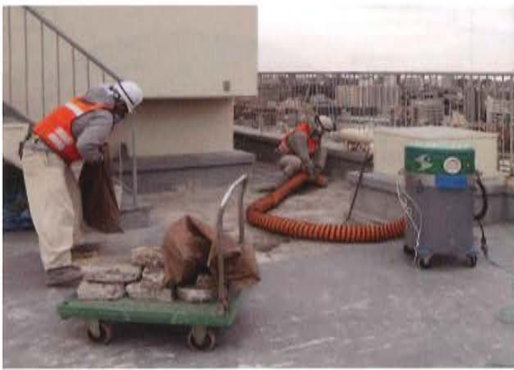
押えコンクリート撤去
