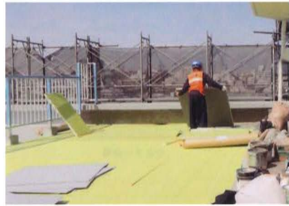
押えコン撤去後、断熱材敷設
