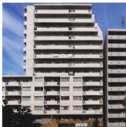
補強前の外観
