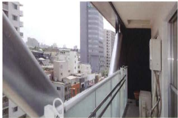
フレーム設置後のバルコニー
