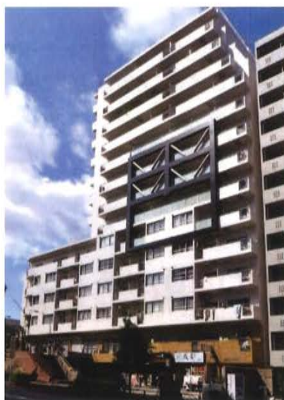
補強後の外観
