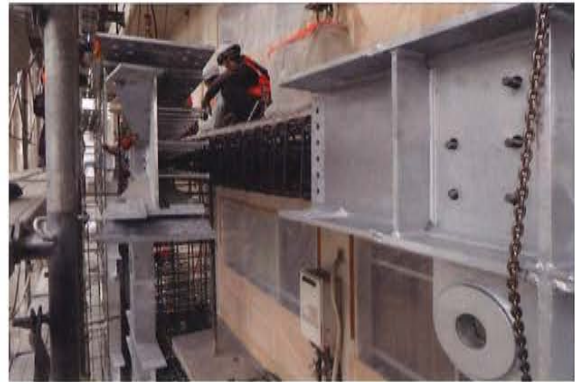
フレーム先端に鉄骨ブレース設置
