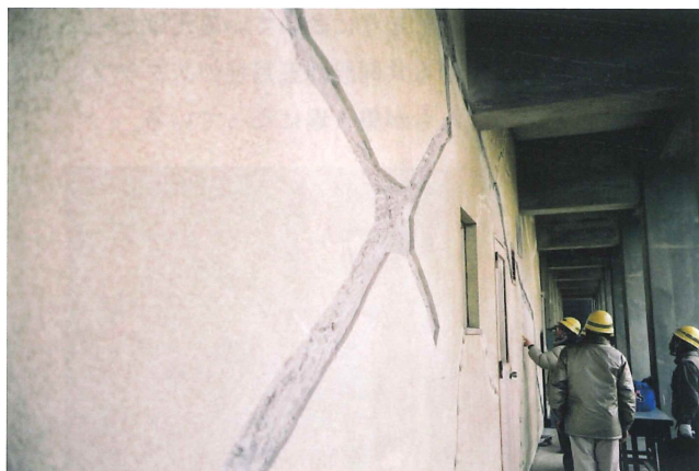
阪神大震災復興工事視察
