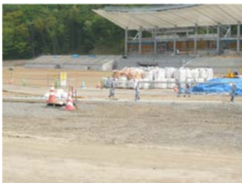
釜石市 スタジアム建設 ラグビーW杯で使用する予定
