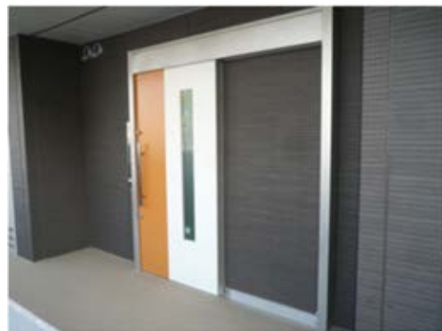
女川町 志津川東住宅 玄関ドアが引き戸になっている
