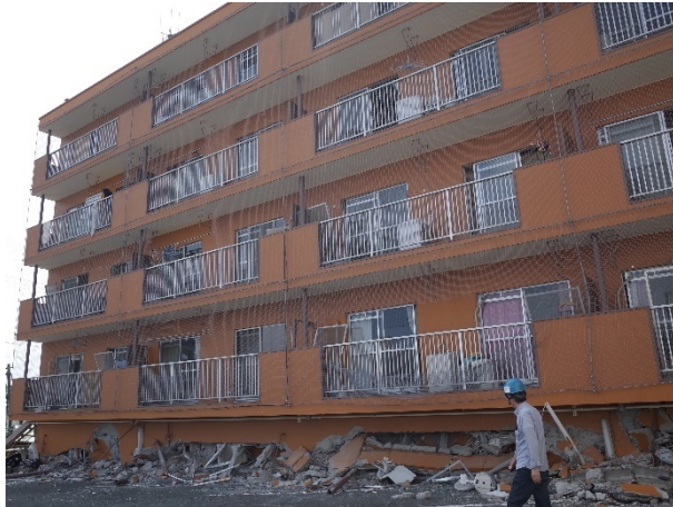
1階部分が圧壊したマンション
