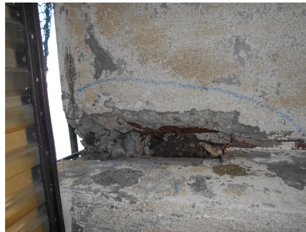
コンクリートの剥落、欠損
